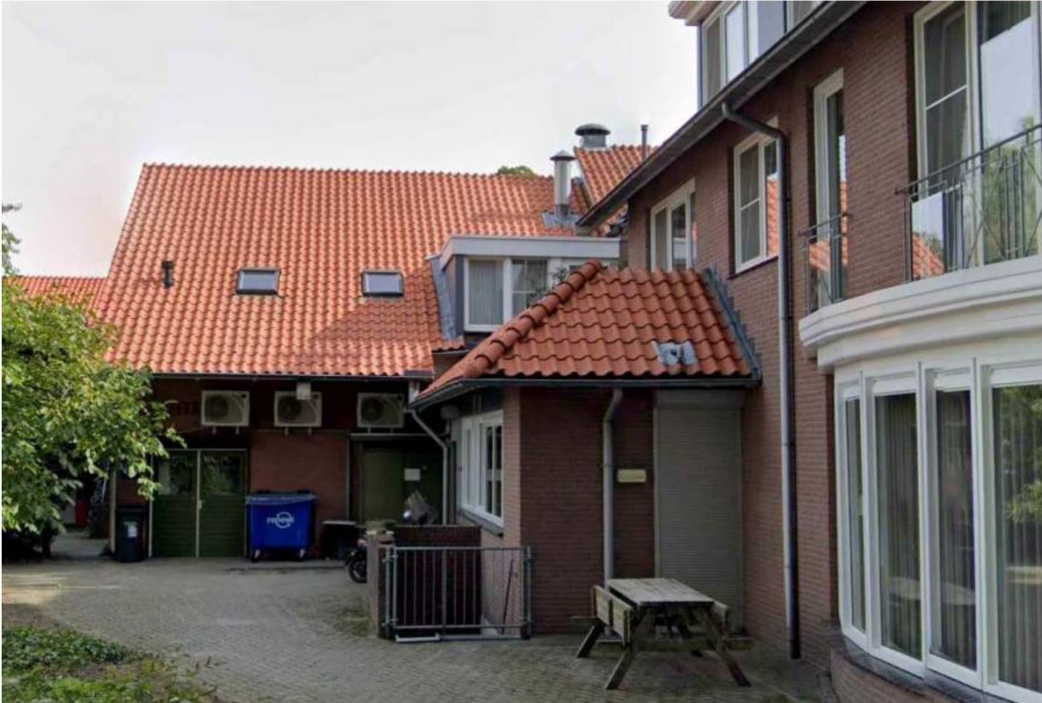
Afbeelding 2.2 Foto's bestaande afzuiginstallatie
