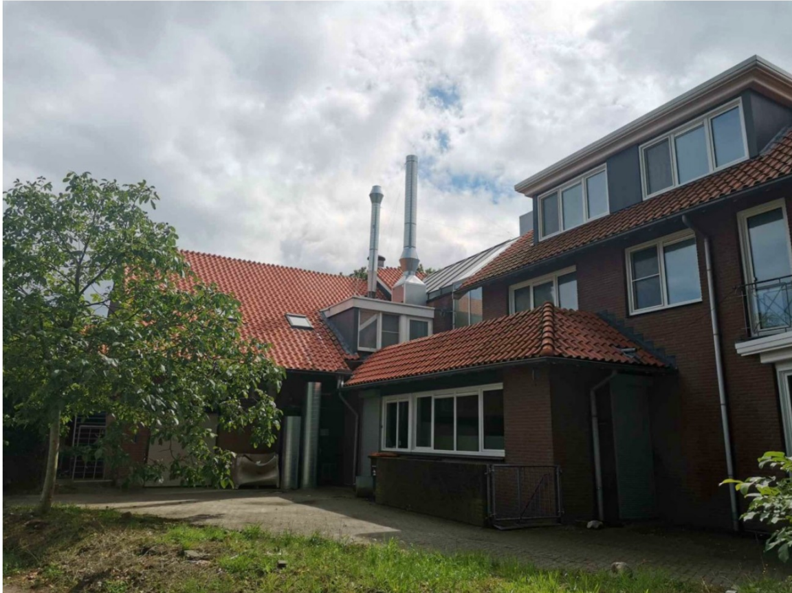
Afbeelding 2.3 Foto's nieuwe afzuiginstallatie
